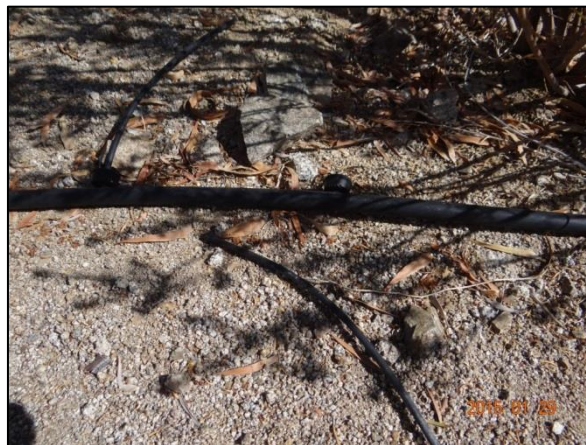
Fotografía 4-6: Vista de microtúbulo desconectado de gotero.
