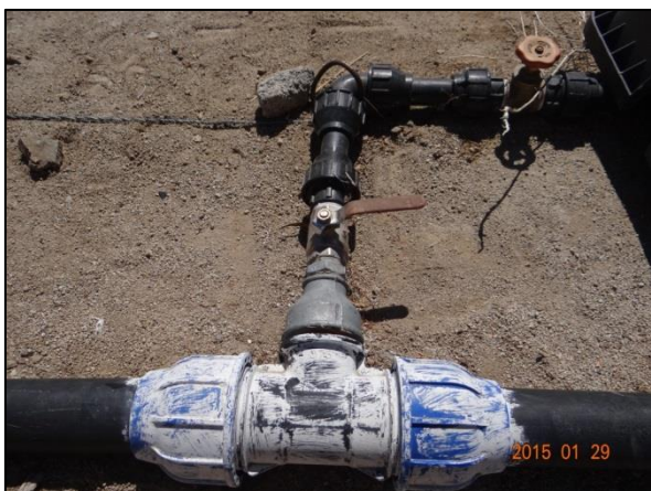
Fotografía 4-3 : Manifold de sector de riego.
